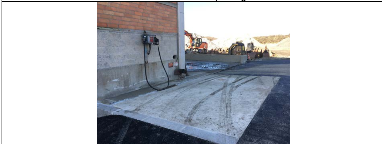
Aire de rétention en béton de la zone de remplissage des camions de la société
